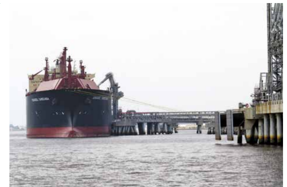
Caption: LNG cargo delivery.
